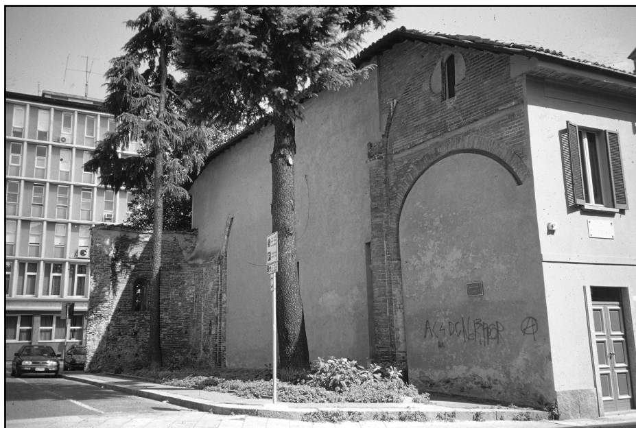
15. L'aiuola corrispondente alla demolizione della chiesa di San Zeno.
