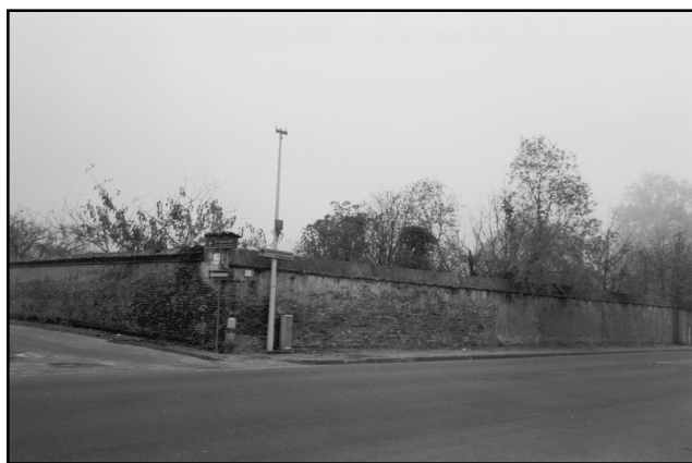
6. Il muro di cinta del giardino di San Giacomo della Vernavola.
